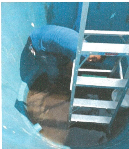
รูปภาพที่ 2.27 การล้างทำความสะอาดถังเก็บน้ำสำรอง
